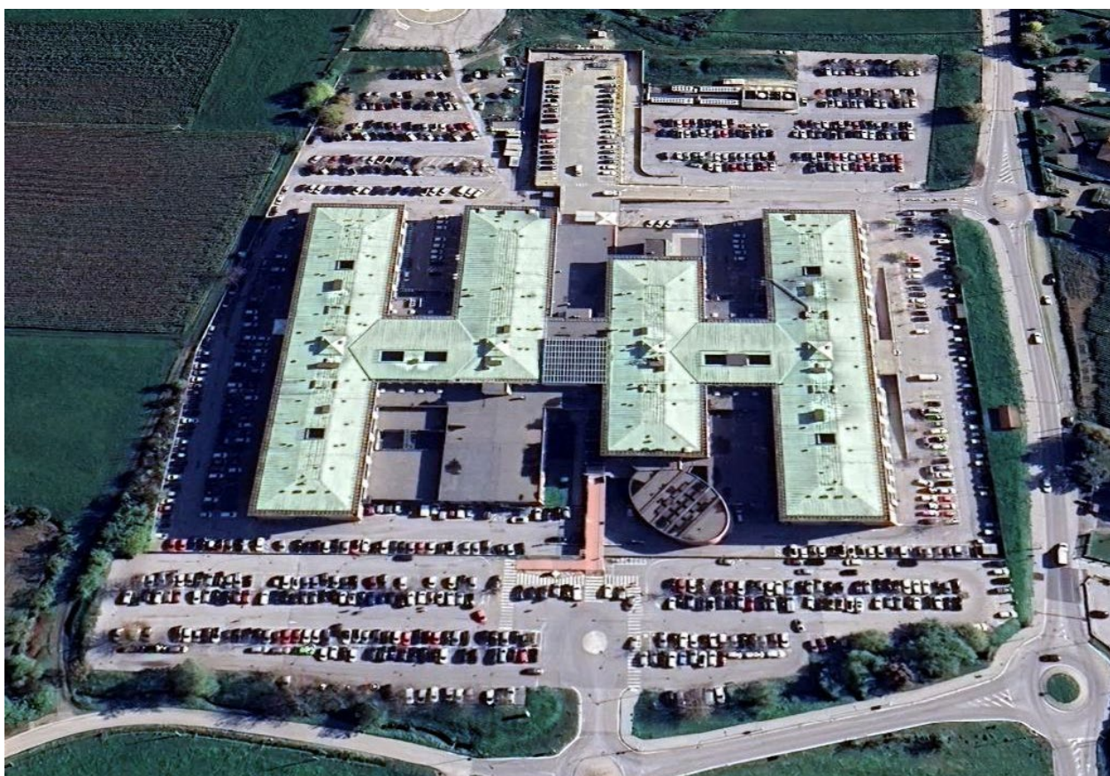
VISTA AEREA DELL'INSEDIAMENTO
