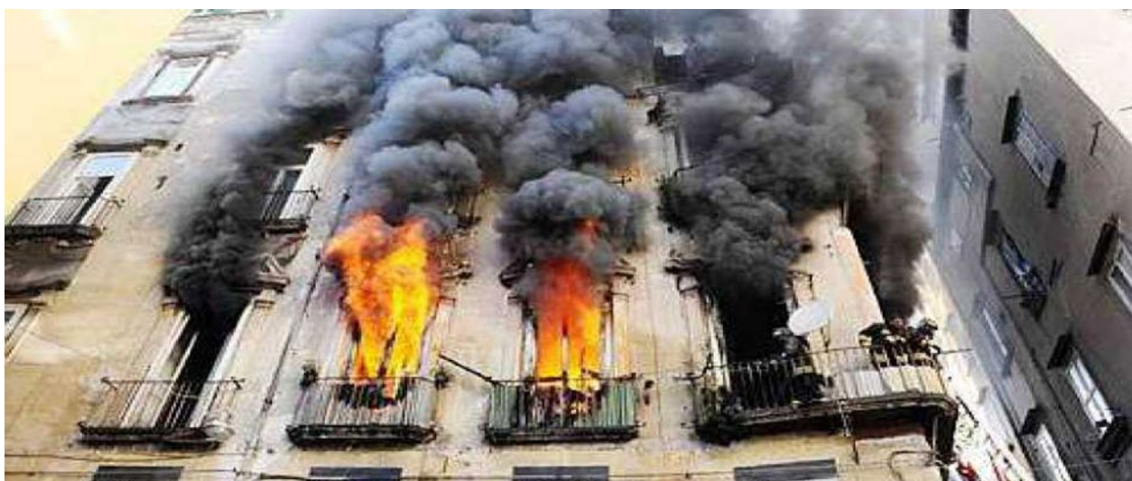
PROPAGAZIONE DELL'INCENDIO SULLA FACCIATA
